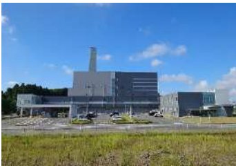
※施設正面外観※
